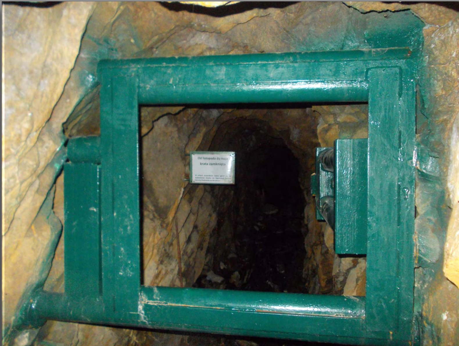
Drzwi do kraty są blokowane w pozycji otwartej i umieszczana jest informacja kiedy obiekt jest otwierany i kiedy jest zamykany. The door to the grate is locked in the open position and information is provided when the object is opened and when it is closed.
