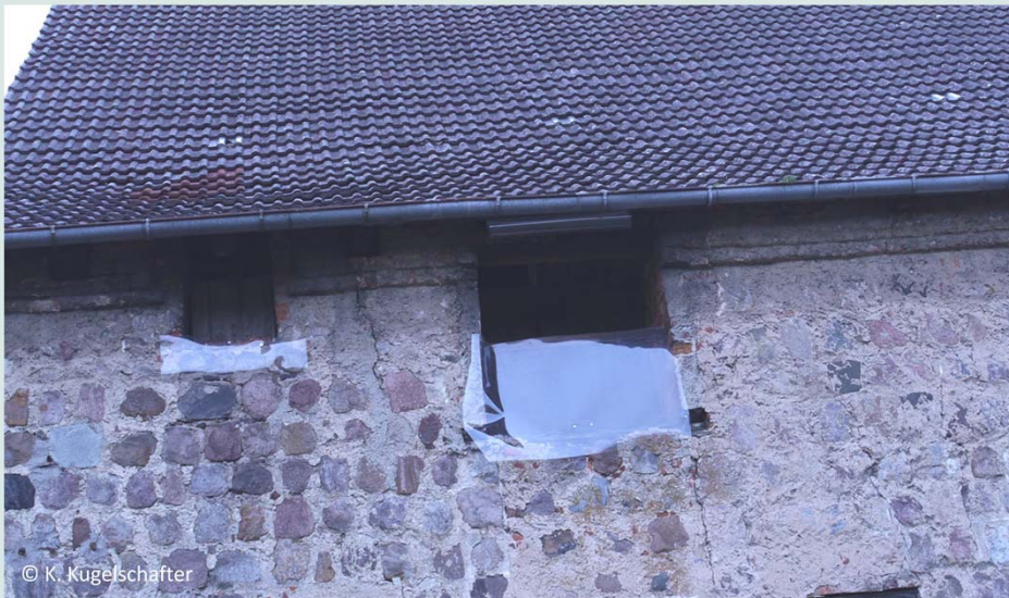
7.4.2015: Installation eines Marderschutzes
